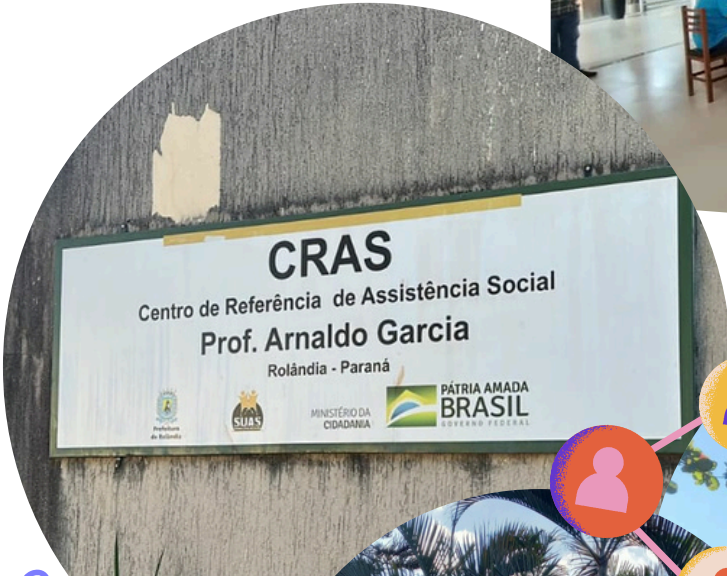
Fachada 03 CRAS de Rolândia
