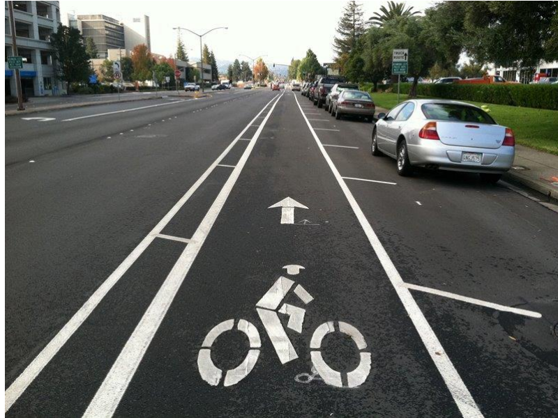
Figura 144 – Pista ciclável com proteção para abertura de portas em Santa Clara, EUA.
