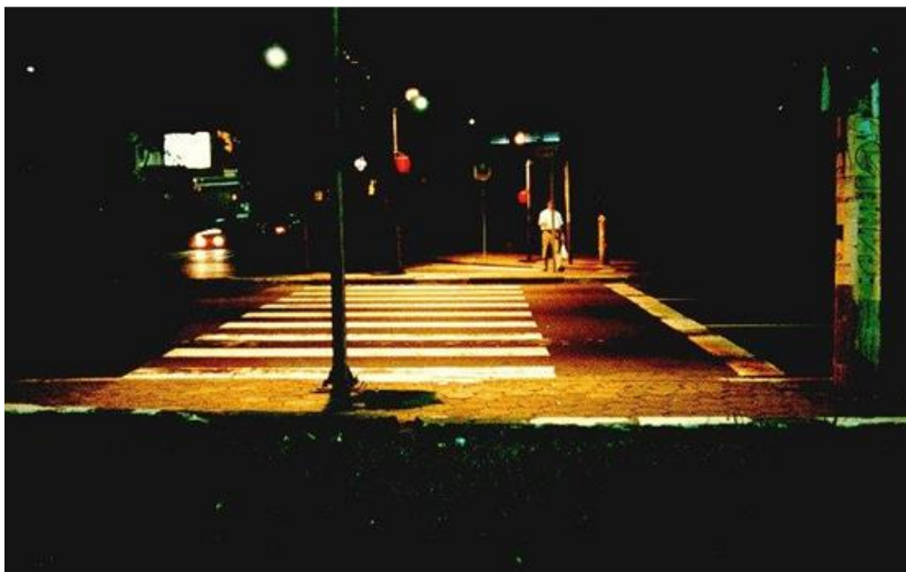
Figura 128 – Exemplo de faixa iluminada na avenida Santo Amaro com rua Américo Brasiliense, em São Paulo-SP.
