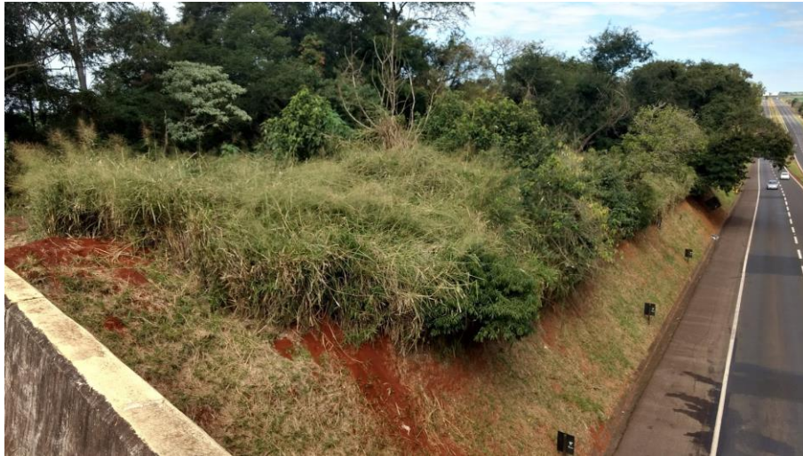
Figura 65 – Possível local para construção de acesso aproveitando a infraestrutura existente.
