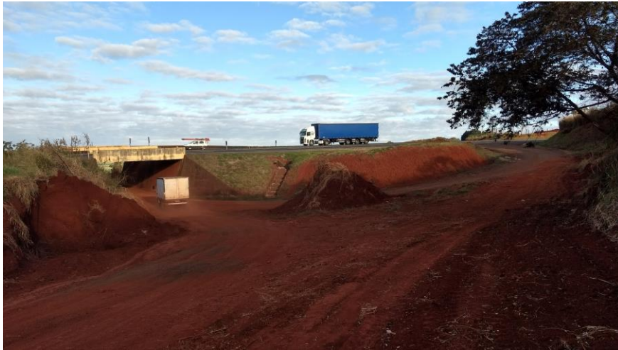
Figura 67 – Infraestrutura sub utilizada na estrada do Cafezal.
