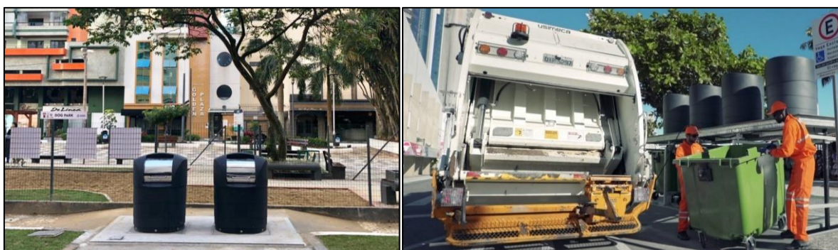
Figura 3 - Exemplo de Sistema de Contentores Subterrâneos Fonte: Estudos do PMI 001/2022
