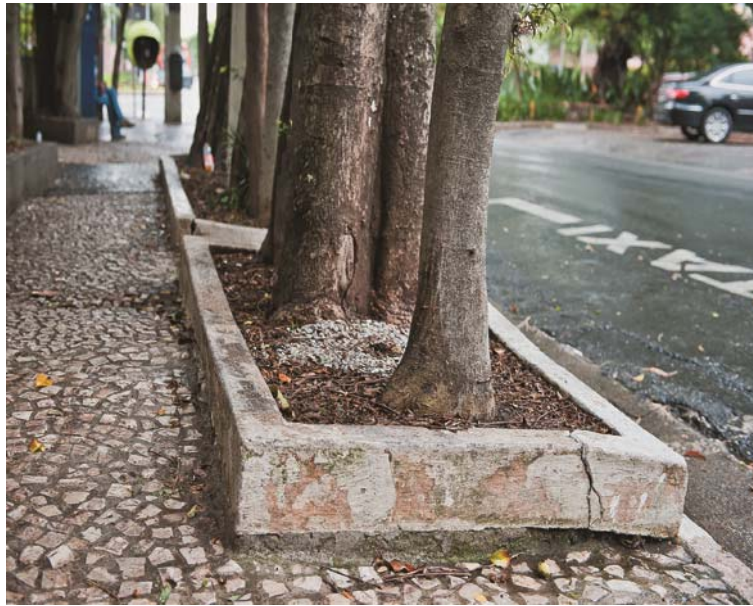
Figura 4.8 - Muretas ao redor da árvore dificultando a infiltração de água.
