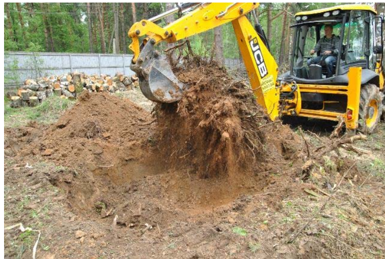
Figura 4.34 - Remoção do toco por escavação mecanizada.
