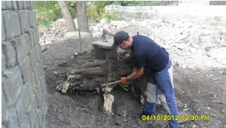
Figura 4.33 - Remoção do toco por escavação manual.
