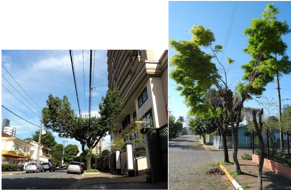
Figura 4.24 - Poda direcional para desobstrução de redes elétricas
