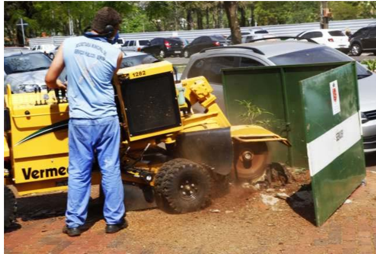
Figura 4.35 - Remoção do toco com equipamentos específicos.
